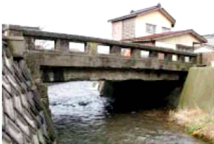
写真-1 損傷が進行したコンクリート橋
