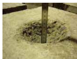
普通コンクリート
