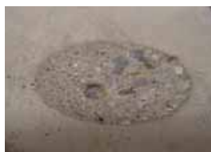
普通コンクリート
